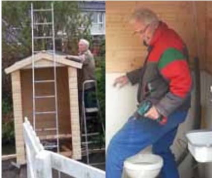
Het Gemak in aanbouw met Dirk en Jan van der Slik
