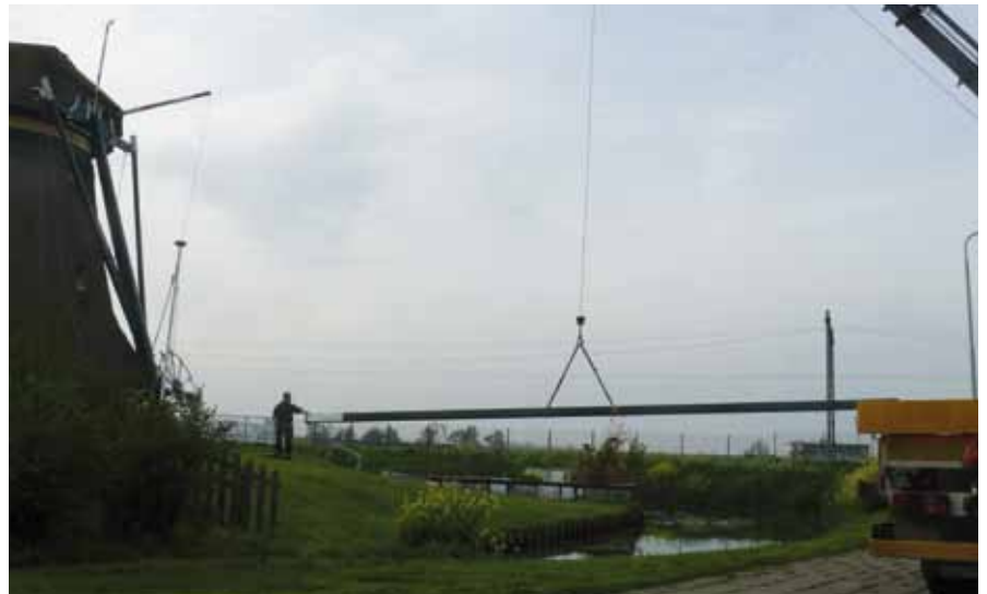
De lange schoor wordt aangevoerd
